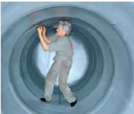
Erdverlegte Tanks müssen bis zum Jahr 2014 saniert oder ausser Betrieb genommen werden. Das heisst, bei einwandigen Tanks muss eine Doppelwandigkeit erstellt und der Tankschacht abgedichtet werden.
