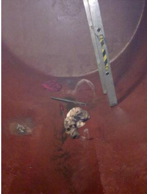
korrodierter Tank (Wassereintritt)
